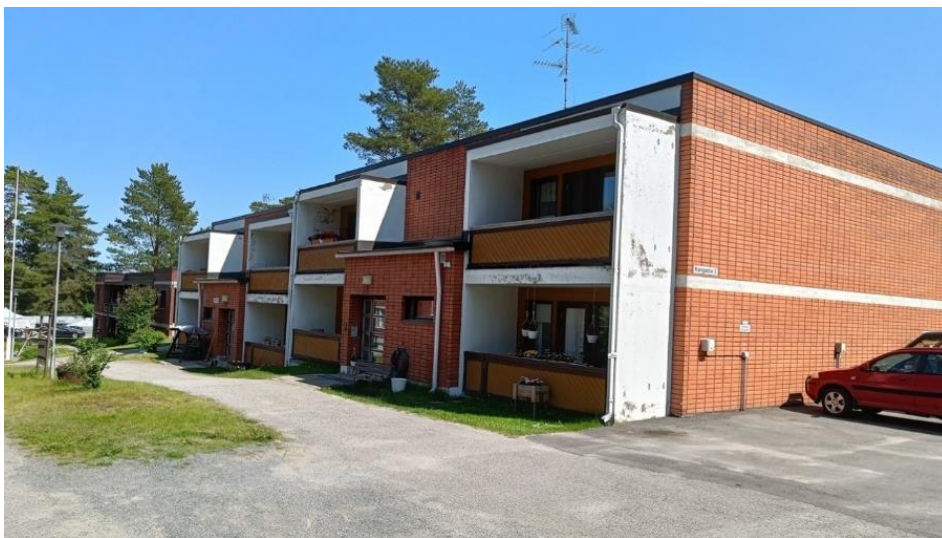
Kuva 12. Rivitalo sijaitsee kiinteistössä 681-421-7-21 (Kangastie 2).
