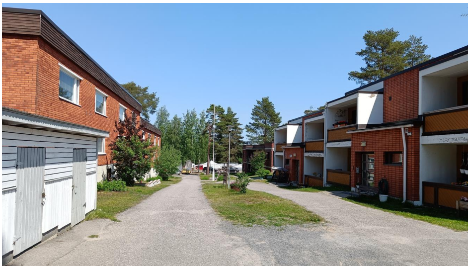
Kuva 13. Rivitalot sijaitsevat kiinteistöissä 681-421-7-21, 681-421-7-22 ja 681-421-7-50, kuva piha-alueesta.
