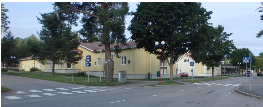
Kuva 5 Vasemmalla palvelukoti Kuusela, taaempana oikealla entinen lääkärin talo.
