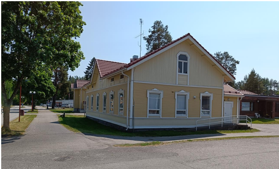
Kuva 21. Entinen lääkäritalo, kuva Kylätien pohjois-suunnasta.
