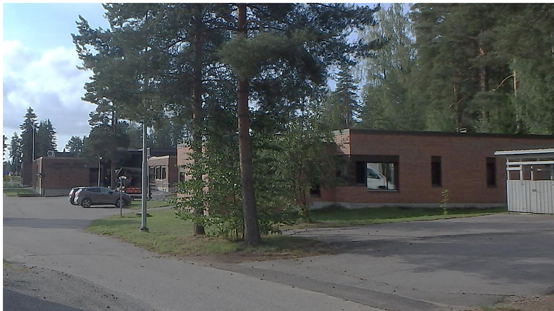
Kuva 18. Palvelukeskus Mäntylä oikealla, taempänä terveyskeskuksen sairaala.
