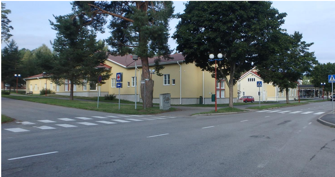
Kuva 24 Vasemmalla palvelukoti Kuusela, taaempana oikealla entinen lääkärin talo.
