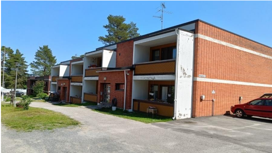
Kuva 21. Rivitalo sijaitsee kiinteistössä 681-421-7-21 (Kangastie 2).
