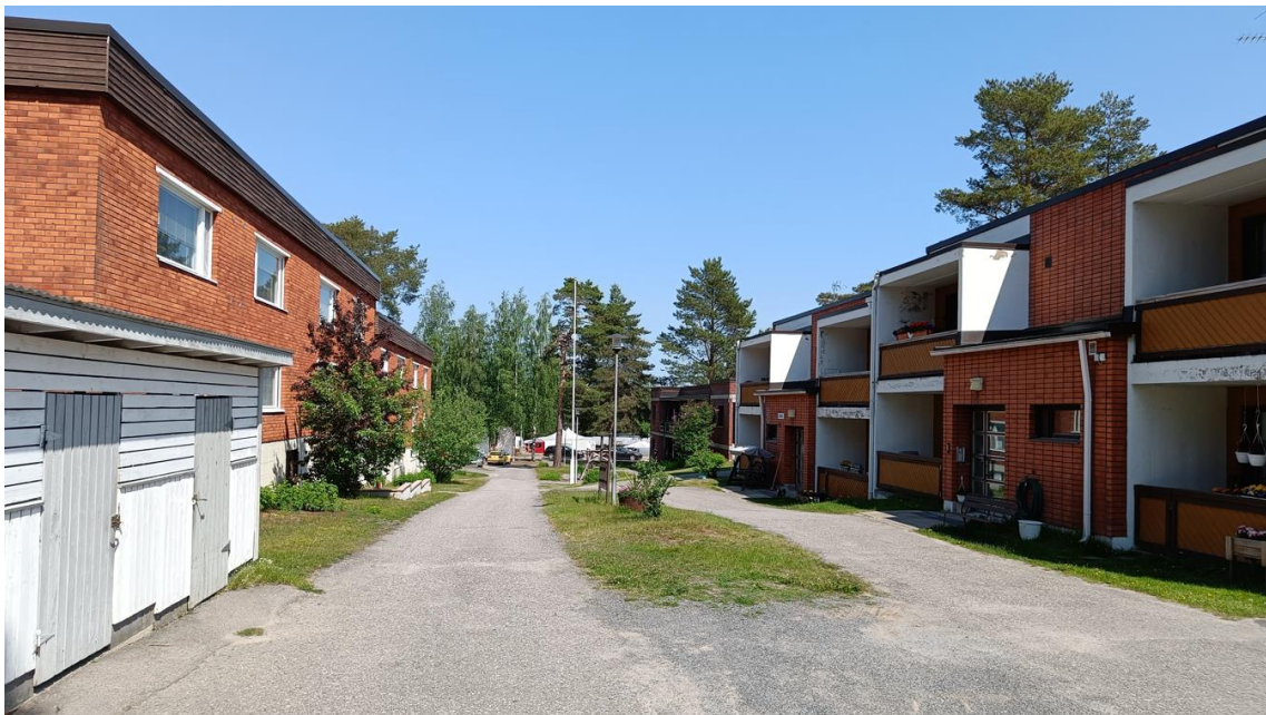
Kuva 22. Rivitalot sijaitsevat kiinteistöissä 681-421-7-21, 681-421-7-22 ja 681-421-7-50, kuva piha-alueesta.
