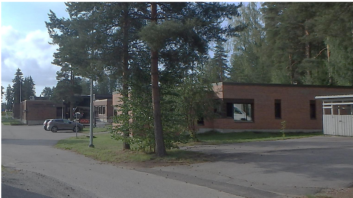
Kuva 18. Palvelukeskus Mäntylä oikealla, taempaan terveyskeskuksen sairaala.
